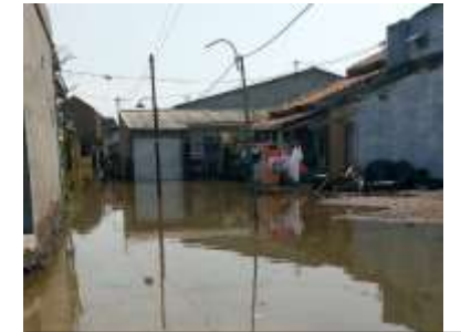
Jalan lingkungan terbuat dari beton, namun tergenang banjir
