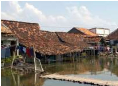
bangunan yang tergenang air rob
