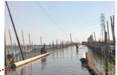
Jaringan jalan lingkungan tergenang banjir rob
