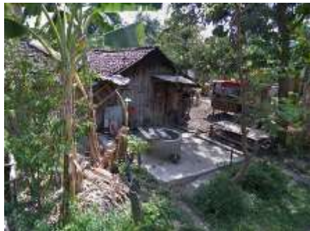
Kondisi rumah kumuh kawasan Brumbung yang berdempetan dan tidak sesuai persyaratan teknis.
