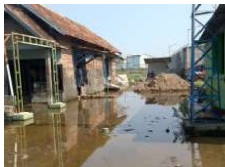
jalan lingkungan tergenang banjir rob
