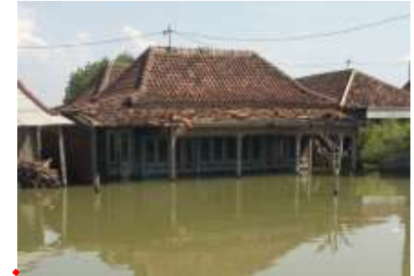
bangunan hunian yang tergenang banjir rob
