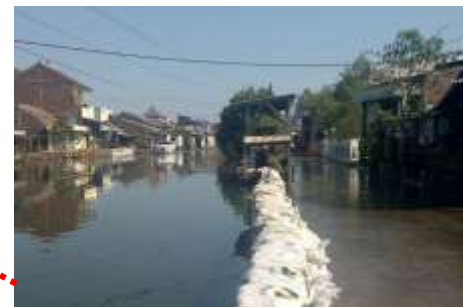
Jaringan drainase yang meluap
