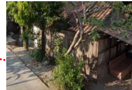
Kondisi Bangunan kumuh di Sayung A
