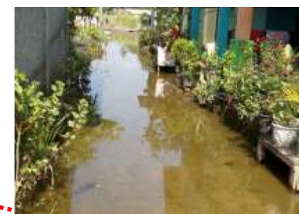
jalan lingkungan tergenang banjir rob
