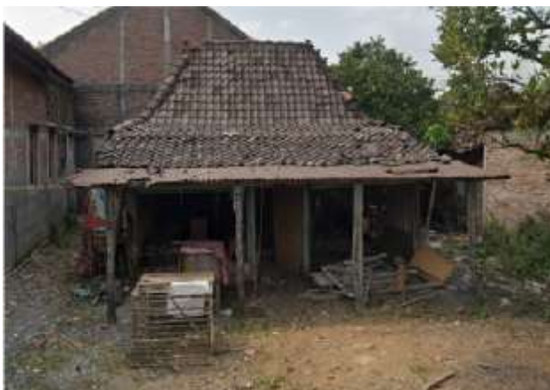
Kondisi Eksisting RTLH
