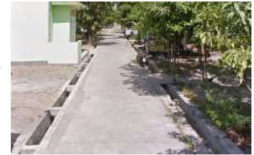
Jalan lingkungan dengan perkerasan beton dan dilengkapi drainase
