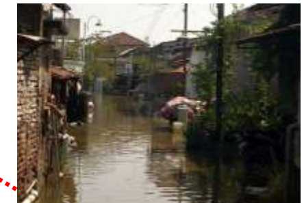
jalan lingkungan terbuat beton, namun tergenang banjir rob
