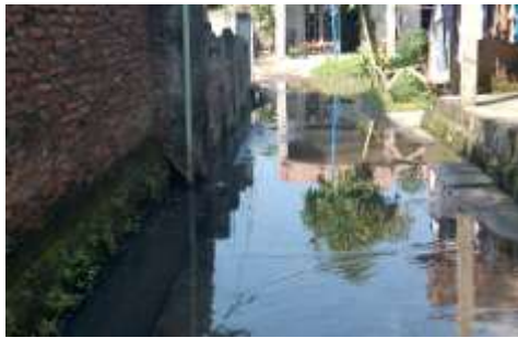
Jaringan drainase tidak mampu mengalirkan air
