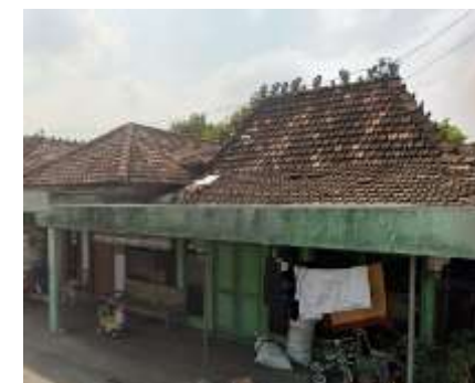
Kondisi Bangunan Kumuh di Tempel-Krajan
