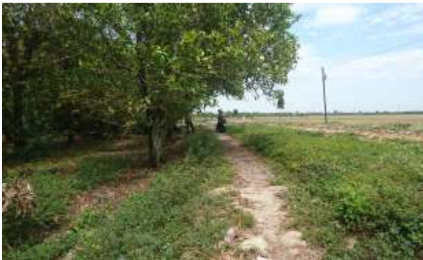
Kondisi Eksisting Jalan tanah
