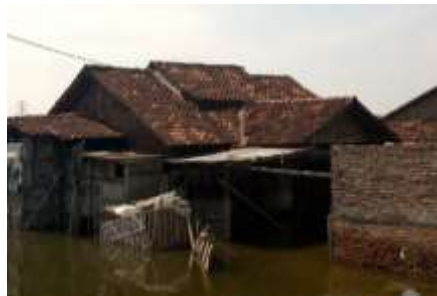
Bangunan hunian yang tergenang banjir rob
